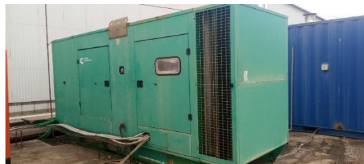
Gerador Cummins - 500KVA
