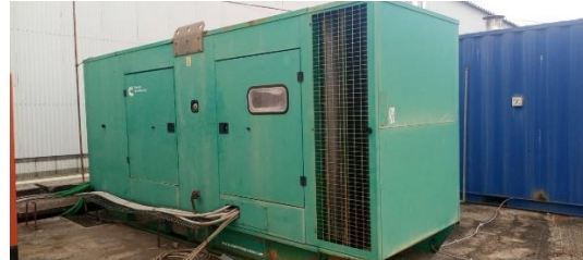
Generator Cummins - 500KVA
