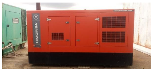
Gerador HIMOINSA de 125KVA
